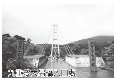
九重夢大吊橋於西元 2004 年 5 月動工，歷經二年半施工，於 2006 年 10 月 30 日正式開通，全長 390 公尺，橋面離溪谷水面之高度達 173 公尺，橋面寬度 1.5 公尺，主塔高度 43 公尺。自開通時起至西元 2015 年 6 月間止，累計遊客已超過 900 萬人，但自西元 2015 年 12 月間全長 400 公尺之靜岡縣三島市的箱根西麓三島大吊橋開通後，已喪失最長吊橋之寶座。
